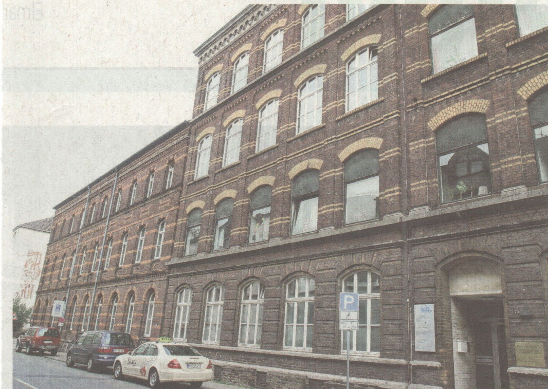
Die frühere Samtweberei in der Tannenstraße: Hier sollen Wohnungen und Gewerbe entstehen. Archivfoto: Lothar Strücken
